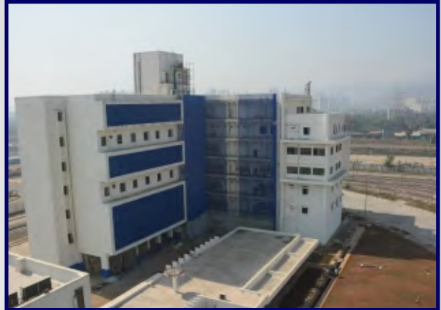
CIDCO Metro Depot
