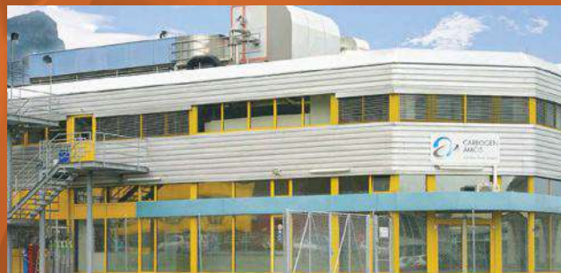
CARBOGEN AMCIS AG, Site - Vionnaz, Switzerland
