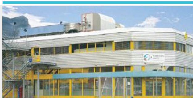
CARBOGEN AMCIS AG, Site Vionnaz, Switzerland
